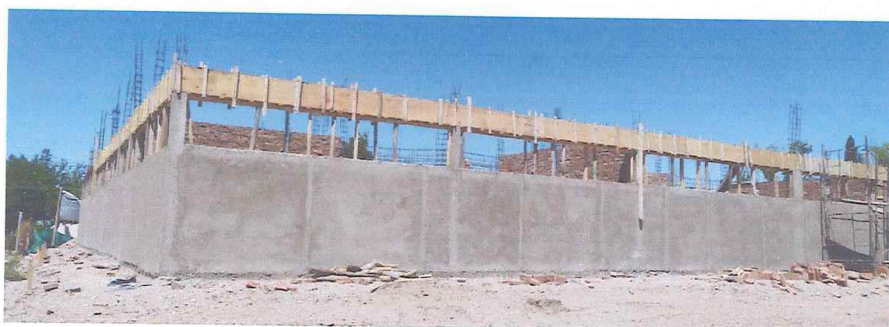
Foto N°8 Vigas de dintel: Encofrado y colado de vigas, chicoteado y revoque grueso impermeable
