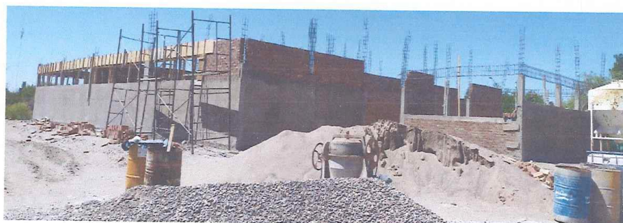
Foto N°9: Mampostería, vigas de dintel, columnas y revoques
