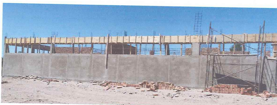
Foto N°7 Vigas de dintel: Encofrado y colado de vigas
